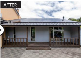
2階建てを平屋へと減築し、屋根も瓦から軽量なガルバリウムに変更。建物が軽くなって、耐震性UPで安心。
