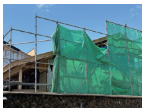
2階の解体が終わり、 平屋の屋根がかかりました
